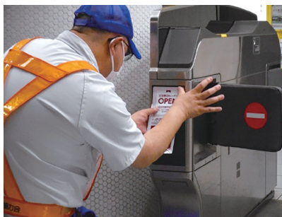
ステッカー広告掲出作業
