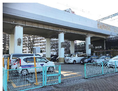
小松川高架下駐車場
